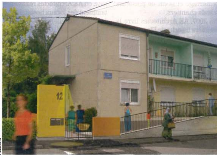
Des totems lumineux et colorés permettent d'identifier les adresses, des «jardins des sens» sécurisés par un portillon en rez-de-chaussée et un cheminement de ceinture autour des bâtiments figurent parmi les éléments de confort d'usage.
